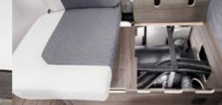
4 Die im Wohnraum platzierte Dieselheizung
